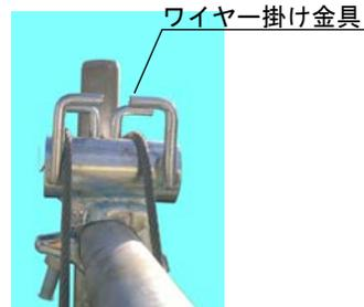
8. 緊張側ワイヤーにスーパークリップを取付ける
